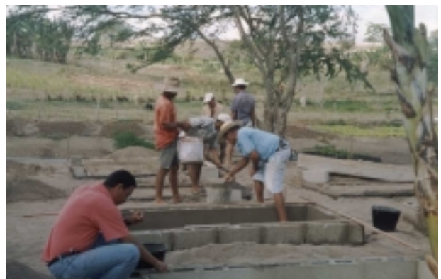
Figura 12. Construção da base da câmara de propagação rápida.
