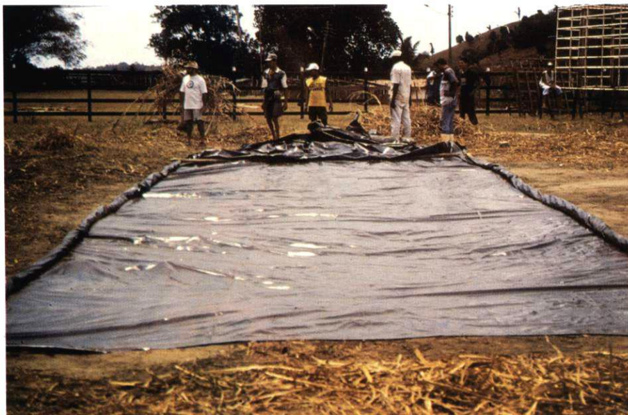
Etapa 1 – Estiramento da lona de polietileno.
