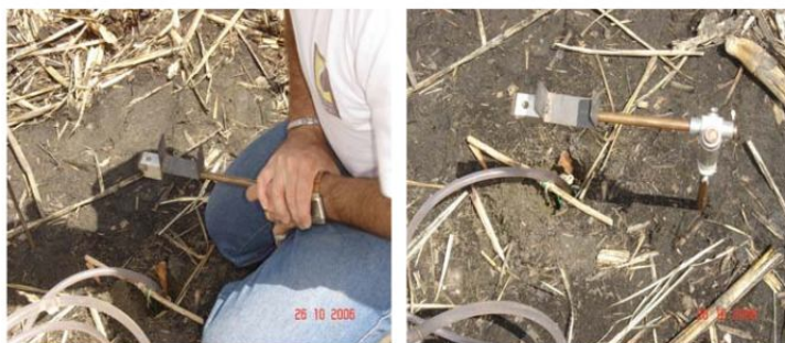
Fig. 16 e 17. Instalação dos suportes.
