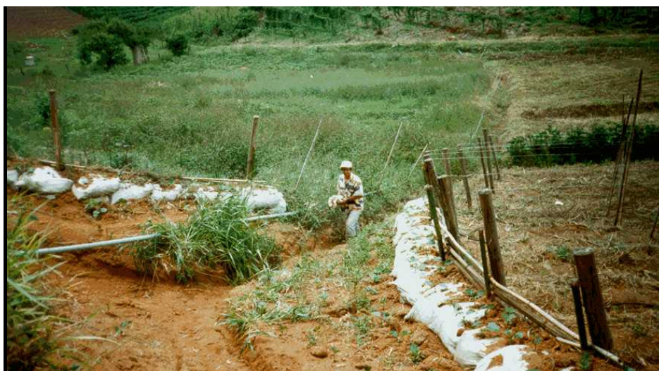
Figura 7.5. Detalhe da proteção dos sulcos com paliçadas.
