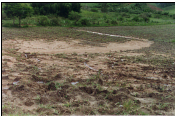
Figura 1. Detalhe de assoreamento.
