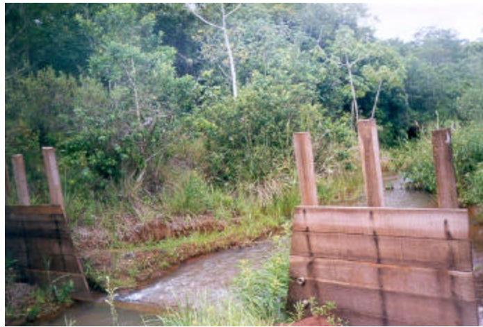
Fig. 5. Vertedor no Córrego do Baixadão, em São Gabriel do Oeste.
