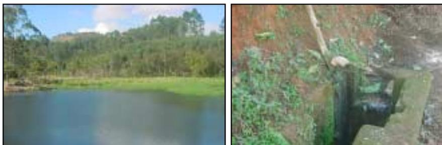
**Fig. 34** - Represa eutrofizada e assoreada e lançamento de esgoto do Bairro Nova Esperança diretamente na mesma.
