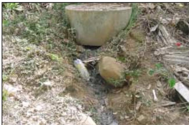
**Fig. 35** - Fossa séptica onde é armazenado o esgoto sanitário proveniente da população do distrito de Dr. Loretti com vazamento.
