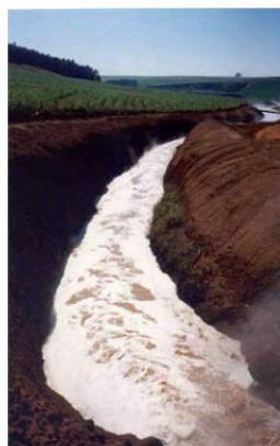
Fig. 15. Canais para o transporte de vinhoto das usinas sucro-alcooleiras até os canaliais.
