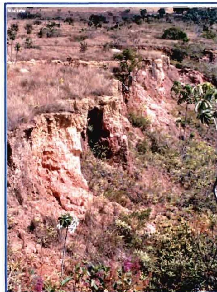
Foto nº22: Voçoroca na borda da segunda superfície, onde o processo erosivo geológico promoveu a remoção total ou parcial da cobertura detritolaterítica e o horizonte C se encontra próximo à superfície.
