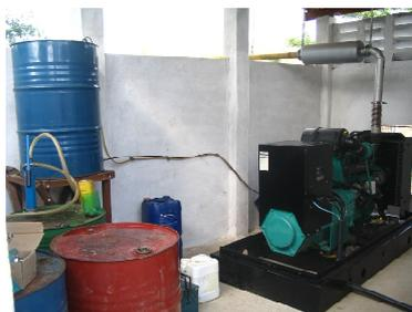
Fig. 12. Grupo-gerador Cummins movido a biodiesel de mamona instalado na Serrinha de Santa Maria, Quixeramobim, CE
