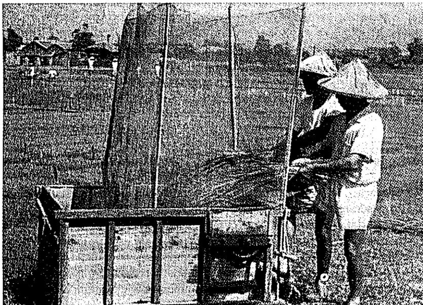
FIG. 2 Trilhadora de arroz a pedal.
