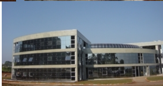
Prédio da nova sede da Embrapa Monitoramento por Satélite em fase de finalização
