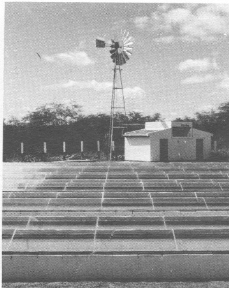
Bombeada através de catavento, a água. . .
