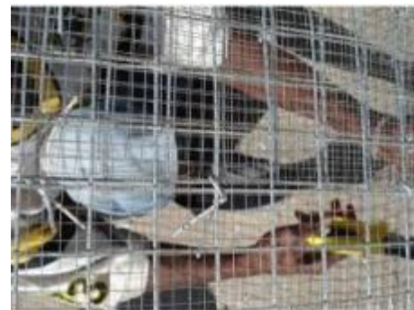
Figura 4. Cortes e emendas de telas fina e grossa de arame galvanizado para suporte do reservatório da cisterna propriamente dita. Corte da tela e início da confecção de 39 placas de cobertura de três cisternas, das quais, duas em Balan-Ganthier e uma na comunidade de Beaugé.
