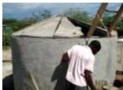
Figura 11. Vista parcial da cobertura da cisterna por meio de placas pré-moldadas, confeccionadas no próprio local de construção da cisterna.
