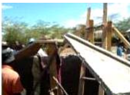
Figura 11. Vista parcial da cobertura da cisterna por meio de placas pré-moldadas, confeccionadas no próprio local de construção da cisterna.
