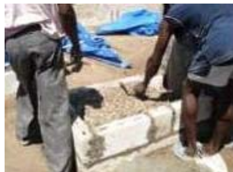
Figura 10. Aplicação da segunda camada de argamassa interna e início da construção da escada de acesso ao reservatório.
