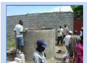
Figura 17. Cisterna para uso com irrigação de salvação.
