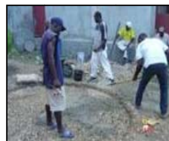
Figura 16. Compactação e nivelamento com água da base do reservatório da cisterna (raio de 1,57 m), e na foto à direita início da concretagem do contra-piso com 7,0 cm de espessura.
