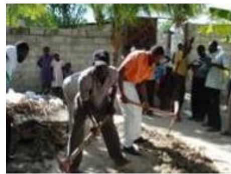
Figura 3. Participação dos treinandos na demarcação e escavação da base do reservatório da cisterna cilíndrica de alambrado (tela de arame e argamassa) na comunidade de Beaugé
