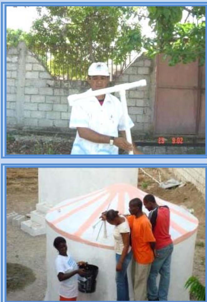
Figura 10. Bomba manual construída no Haiti utilizada para bombear água da cisterna domiciliar, de fácil manejo e de baixo custo, podendo ser construída por pessoas da própria comunidade, desenvolvida pelo IRRPA, Juazeiro – BA.
