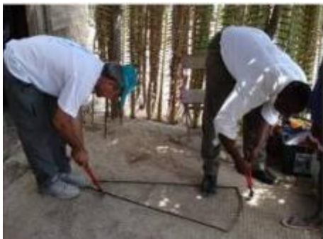
Figura 5. Detalhe da confecção das placas de cobertura das cisternas
