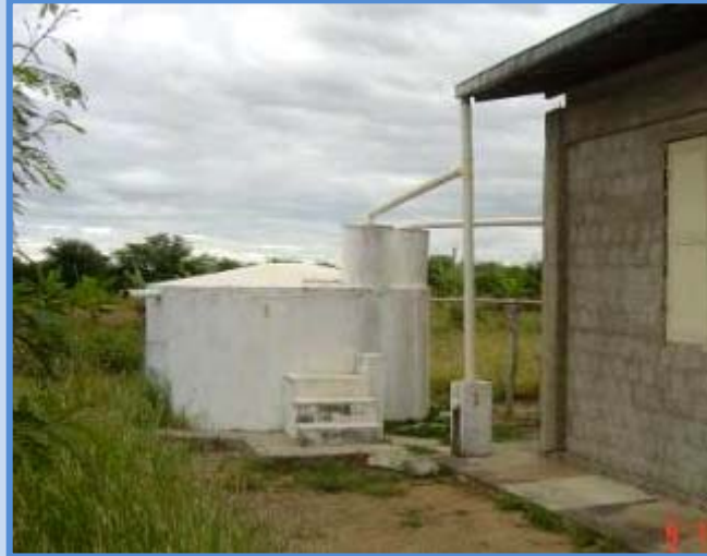
Figura 9. Cisternas de alambrado (tela de arame (+) argamassa (cimento e areia) construídas na Estação Experimental do Instituto Regional da Pequena Agropecuária Apropriada - IRRPA , em Juazeiro – BA. E na segunda foto a esquerda bomba manual, utilizada para bombear água de reservatórios com profundidade de até \leq 5,0\text{m} .
