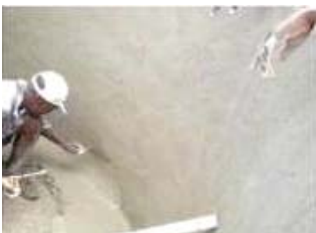
Figura 10. Aplicação da segunda camada de argamassa interna e início da construção da escada de acesso ao reservatório.
