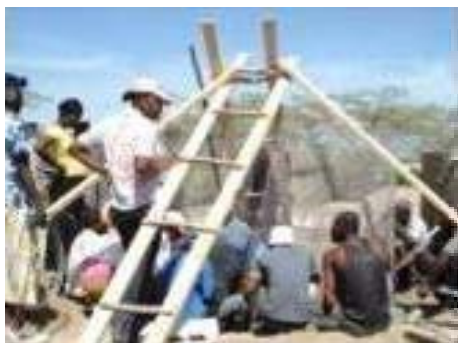
Figura 8. Escoramento e amarração das telas com fio de arame galvanizado.
