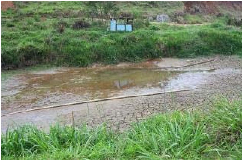
**Fig. 18.** Drenagem completa do lago de pesca para reparar margens, diques e retirar o excesso de sedimentos do fundo dos lagos.
