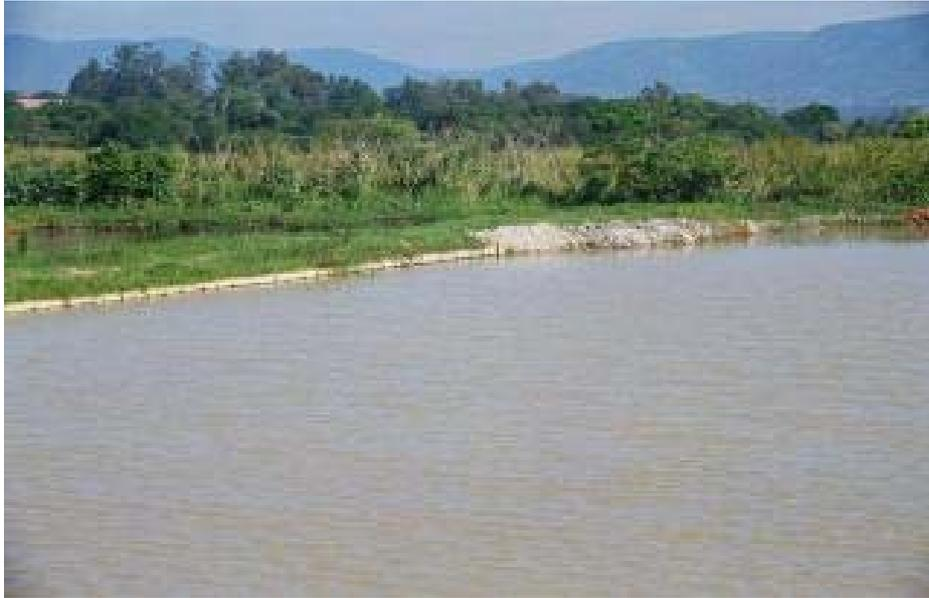
**Fig. 15.** Presença de cobertura vegetal (grama) e revestimento para evitar erosão das margens, além de auxiliar para a melhoria da qualidade da água.
