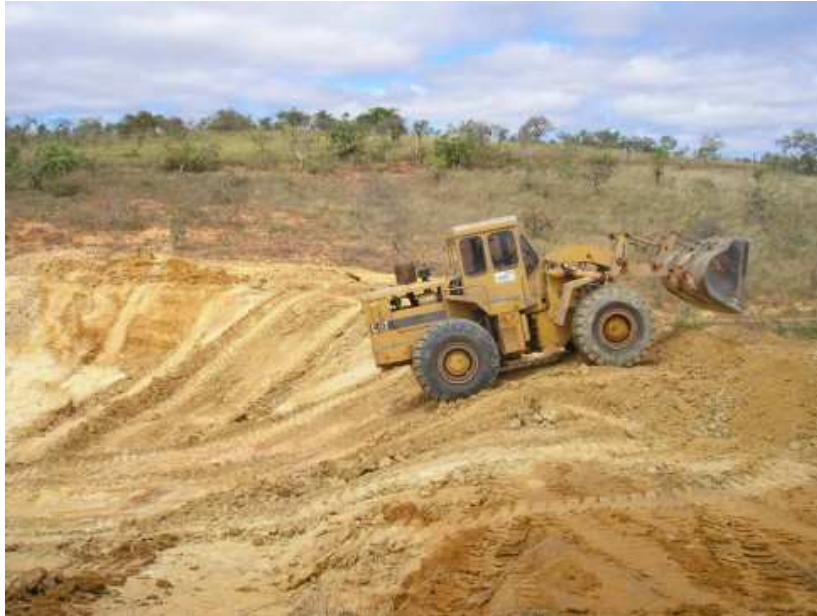
Figura 2: Pá-carregadeira em fase de construção de Barraginhas.
