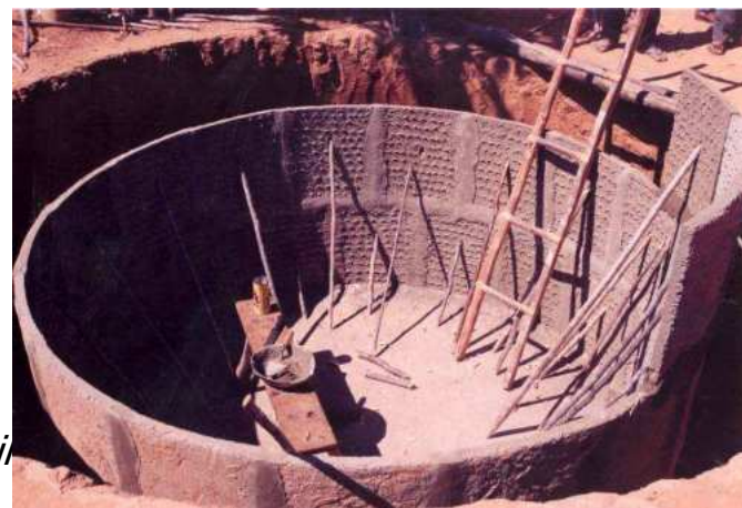
Estrutura de sustentação
