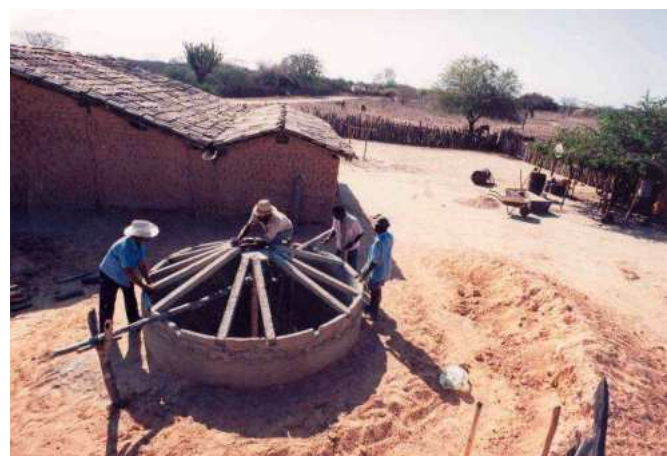
Construção da tampa
