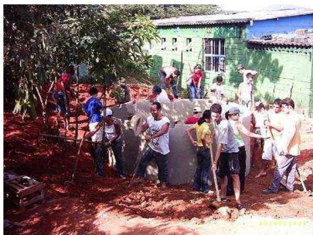
Fig.6: Estudantes construindo uma cisterna de placas em Belo Horizonte com o acompanhamento de um pedreiro construtor de cisternas vindo do Vale do Jequitinhonha-MG.
