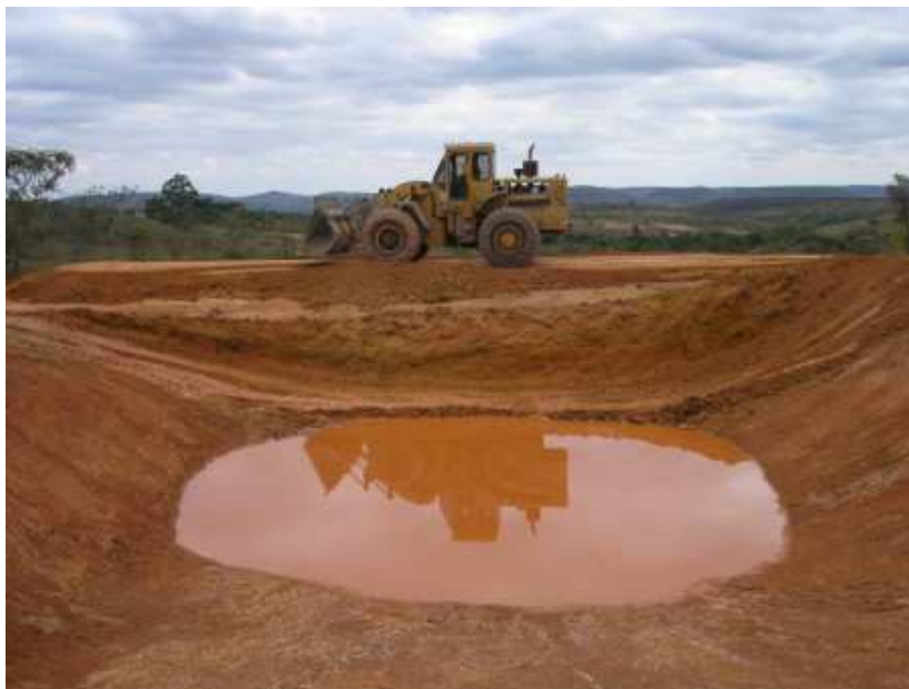
Figura 3: Barraginha em fase de conclusão no início do período chuvoso.
