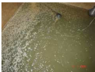
Fig 9: coloração da água na cisterna 24hs após adição do sulfato de alumínio
