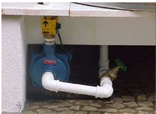
Figura 5- Bomba centrífuga
