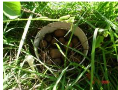
Fig 2: Tubo PVC cheio de argila expandida: visita ao ralo abacaxi
