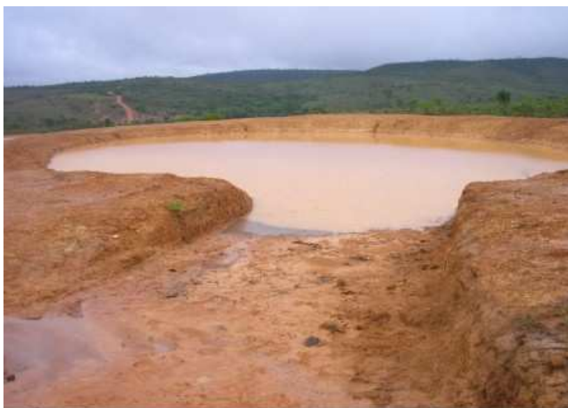
Figura 1: Barragem construída na Comunidade de Abóboras após um mês de construção.
