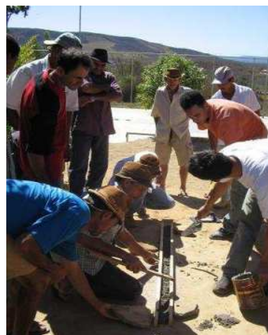
Fig.2: Estudantes e moradores em capacitação para construção de cisternas de placas.
