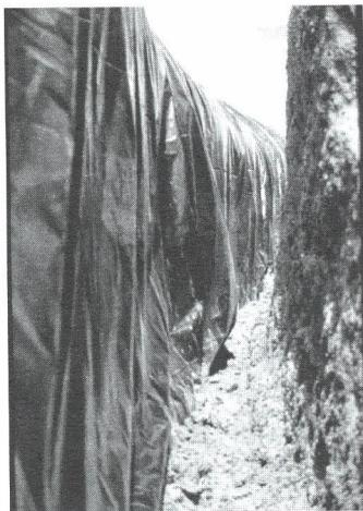
Parede da barragem subterrânea com lona plástica.
