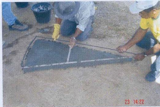
5 - Colocar o molde de ferro (Figura 1) sobre a areia nivelada e preenchê-lo com a argamassa (Figura 4 e 5);
