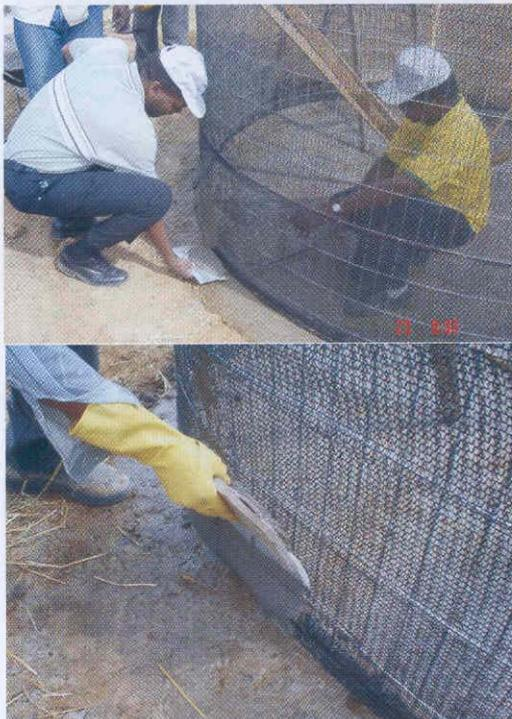
3 - A argamassa deve ser colocada de baixo para cima, começando na parte externa, utilizando-se uma desempoladeira ou espátula flexível de plástico (Figuras 32 e 33);
