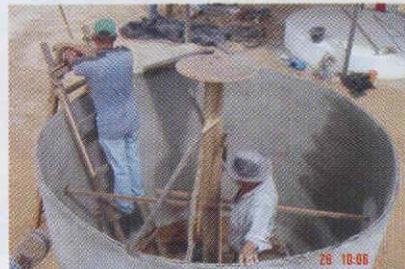
2 - A colocação das placas ocorrem um de cada vez em sentidos opostos. Tendo-se a precaução de se aferir com precisão, para que as mesmas fiquem equidistantes do centro da cisterna, e concontantemente do centro do suporte para que as placas (Figura 41).
