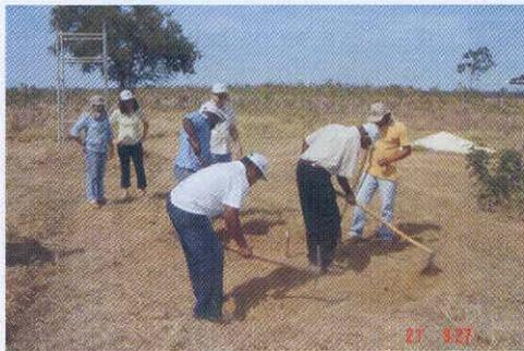
1 - A área para construção da cisterna deve estar situada longe de lixões, currais, fossas ou outros pontos de poluição que possam colocar em risco a qualidade da água e/ou comprometer a estrutura da cisterna (Figura 14). Deve estar próxima a casa, para facilitar a captação da água do telhado;
