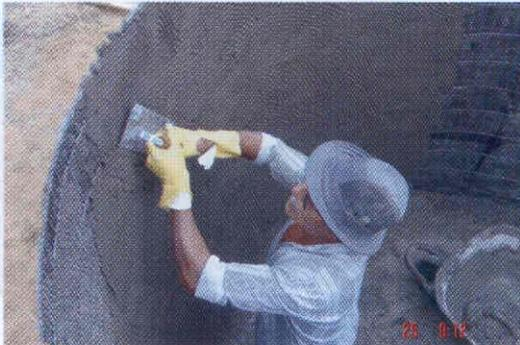
7 - Na primeira camada interna usa-se a argamassa no mesmo traço das camadas da parede externa e utiliza-se a desempenadeira dentada de aço ou similar (Figura 38).
