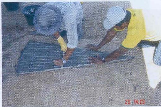
6 - Colocar a tela de alambrado sobre a argamassa, seguida pelo molde de ferro e, novamente preenchê-lo com argamassa Figura 6 a 8;
