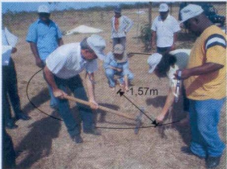
3 - Coloca-se um piquete no centro da área e com um arame amarrado a este e fixado em um outro piquete, marca-se a área com um raio de 1,57 m (Figura 16);
