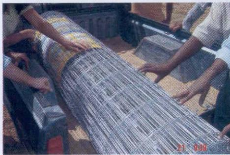
1 - Existem telas galvanizadas de alambrado de diferentes características. A tela utilizada para a construção de cisterna deverá ter as dimensões próximas as apresentadas na Figura 22 (Tela: malha 0,15x0,05m, fio 0,003m);
