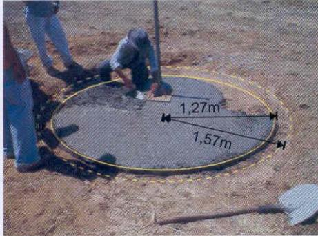
4 - Coloca-se o concreto por cima da areia compactada. O concreto tem **traço 4:3:1** (brita ou seixo rolado, areia, cimento), ou seja, quatro latas de brita ou seixo rolado, três latas de areia grossa e uma de cimento) (Figura 21);
