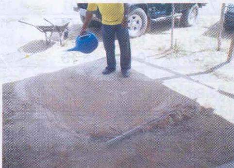
3 - Nivelar o chão com uma camada de areia grossa, molhada e compactada, de forma que as placas fiquem planas para melhor ajuste da cobertura (Figura 3);
