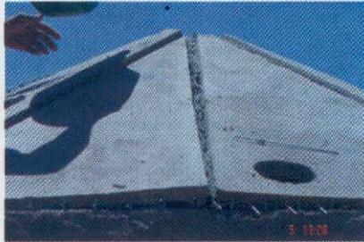
4 - A placa perfurada que irá permitir fixar o tubo de condução de água da área de captação deverá ficar mais próxima do telhado da moradia, visando minimizar os custos, como também a placa perfurada para colocação da bomba manual, conforme figura 43.
