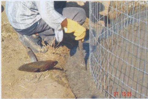
5 - Faz-se o contrapiso da parte externa da tela de alambrado utilizando-se o concreto com o mesmo traço do contrapiso da parte interna (Figura 27).
