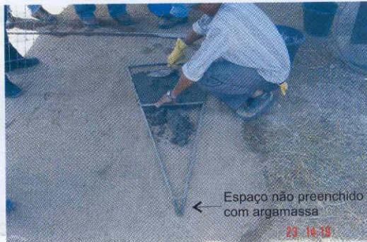
4 - Argamassa: utilizar argamassa no **traço 3:1**, isto é, 3 latas de areia grossa para uma lata de cimento. A argamassa deve ser meio dura;
