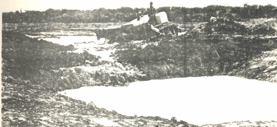
Foto 6. Confeção de um barreiro por meio mecânico.
