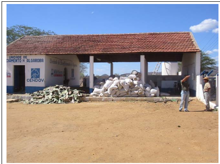
FIGURA 10 – Unidade de beneficiamento de vagens de algaroba, em Monteiro – Paraíba
