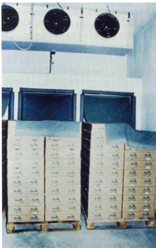
Fig. 19. Sistema de pré-resfriamento por túnel de ar forçado.
