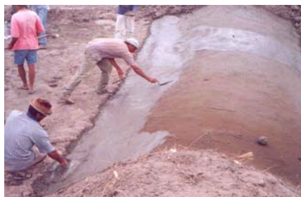
Fig. 8. Construção do sangradouro (revestimento com argamassa).
