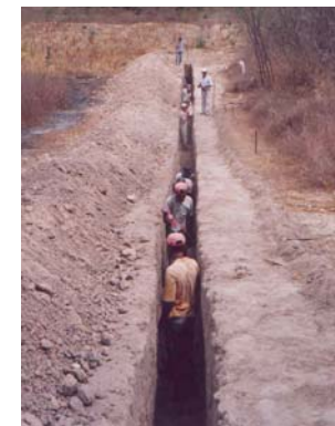
Fig. 3. Abertura da valeta.
