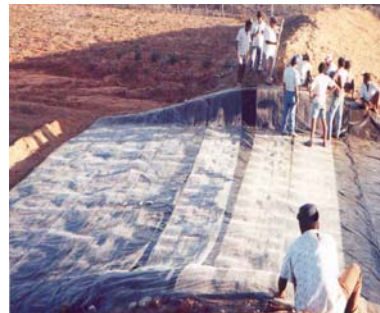
Figura 7. Construção do sangradouro (colocação da tela de arame tipo pinteiro).
