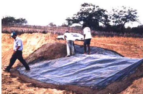
Fig. 6. Construção do sangradouro (colocação da lona plástica)
