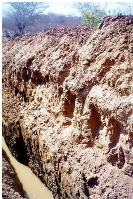
Fig. 1 – Escavação de vala profunda para implantação do septo impermeável no Município de Jataúba – PE
