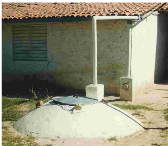
Ilustração 7: Cisterna de tijolos e argamassa de cal
