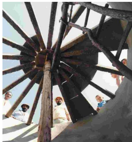
Ilustração 2: Armação da cobertura (visto por dentro da cisterna)
