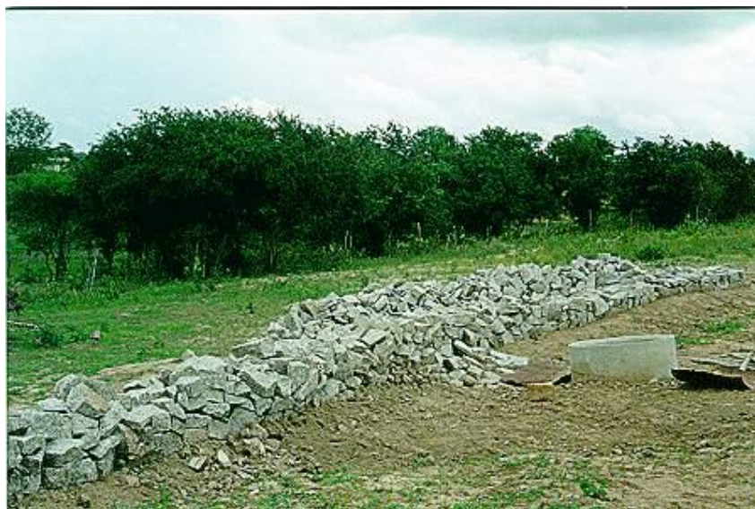
Figura 3 -Enrocamento de pedras sobre a barragem já fechada. Vê-se ainda o poço amazonas
