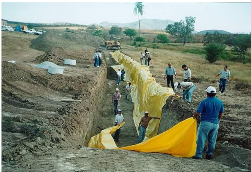
Figura 2 - Colocação da lona na vala escavada no aluvião
