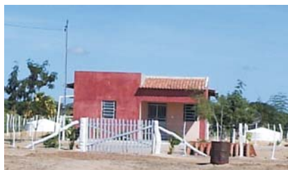
Fig. 2. Cisternas de placas pré-moldadas com 8,0m 3 cada.
