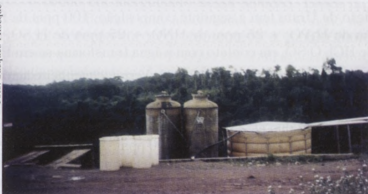
Fig. 32. Sistema de tratamento de água de córrego com betonina, Camamu, BA.
