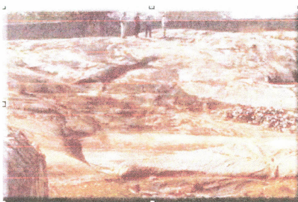
Figs. 73 e 74. Sistema de implúvio: a esquerda, superfície rochosa cujo elevado escoamento superficial conduz a água captada da chuva para uma pequena barragem, à direita. Município de Santa Rosa-PB.
