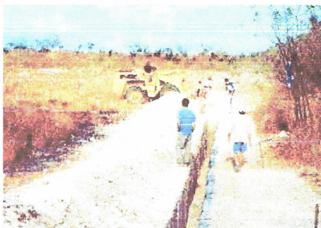
Figs. 82 e 83. Construção de uma barragem subterrânea: à esquerda, escavação da vala e colocação de lona plástica e escavação de valeta no topo da superfície a jusante; à direita, detalhe da colocação da lona plástica (Silva et al , 2001).
