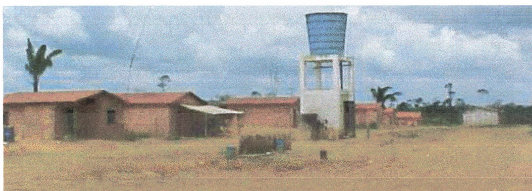
Fig. 35. Poço tubular numa agrovila do INCRA, onde a água subterrânea é bombeada de uma profundidade de 250-280m (estando o nível estático aos 80-100m). Município de Bom Jesus das Selvas – MA.
