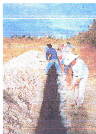
Figs. 82 e 83. Construção de uma barragem subterrânea: à esquerda, escavação da vala e colocação de lona plástica e escavação de valeta no topo da superfície a jusante; à direita, detalhe da colocação da lona plástica (Silva et al , 2001).
