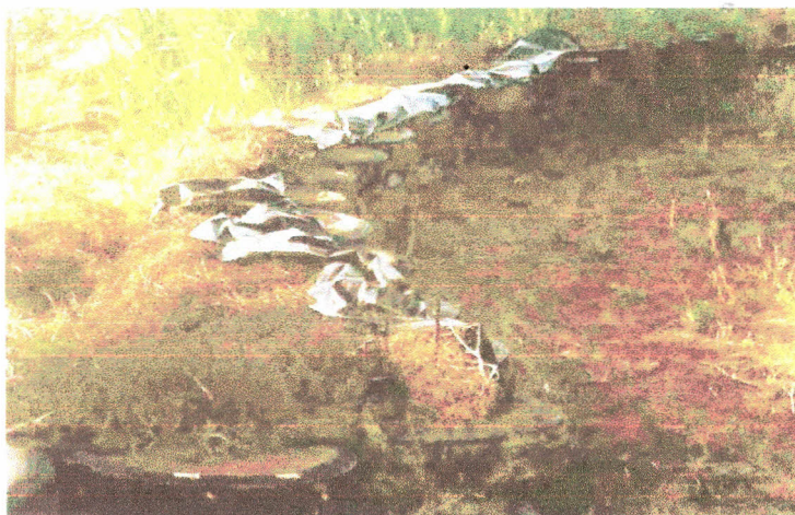
Fig. 84. Barragem assoreadora, construída de forma elementar com pneus empilhados, amarrados e protegidos com lonas plásticas. Serve para produção de culturas na área sedimentar formada pelo material assoreado à montante (UFPB, 2000).
