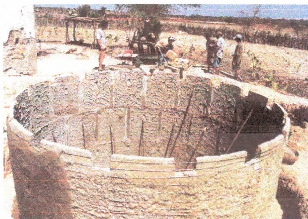
Figs 68 e 69 – Etapas inicial e final da construção de uma cisterna de placa com capacidade para 15.000 litros. Modelo para atender a necessidade primária indispensável para a zona semi-árida (Fotos Franca, 2003).
