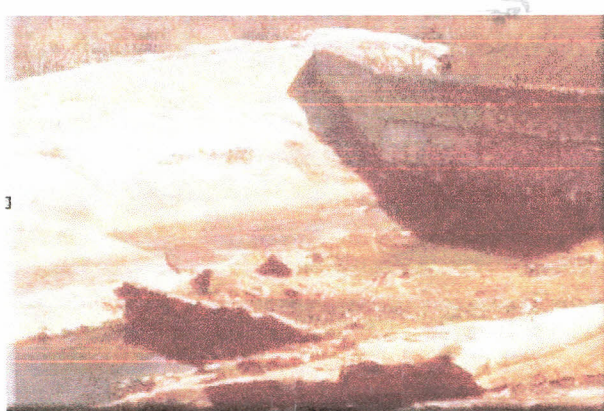
Figs. 73 e 74. Sistema de implúvio: a esquerda, superfície rochosa cujo elevado escoamento superficial conduz a água captada da chuva para uma pequena barragem, à direita. Município de Santa Rosa-PB.
