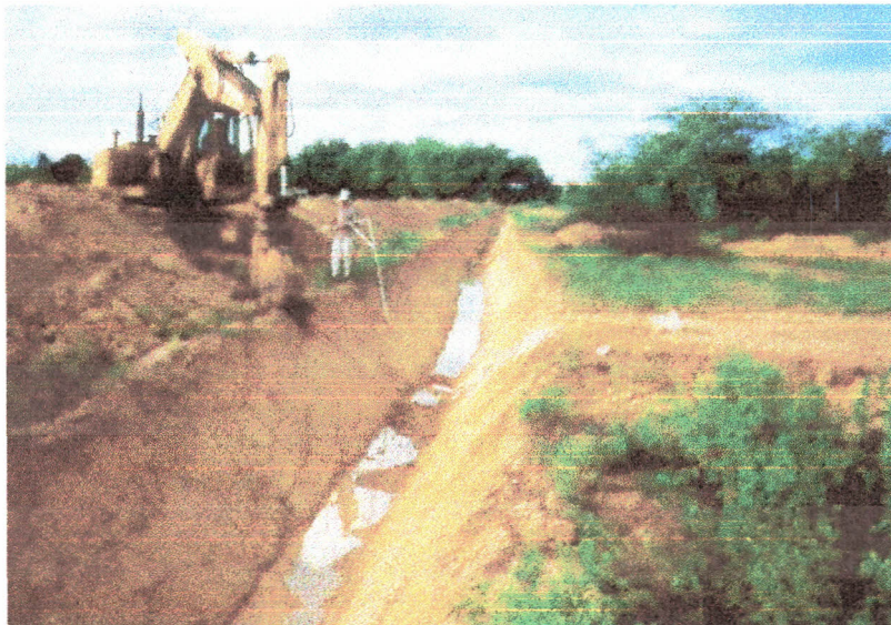
Fig. 60. Terraço fluvial, onde está sendo executado um perfeito sistema de drenagem, vendo-se um dreno coletor, para onde convergem os drenos paralelos em tubos enterrados. Ilha de Assunção, no Rio São Francisco, Cabrobó-PE.
