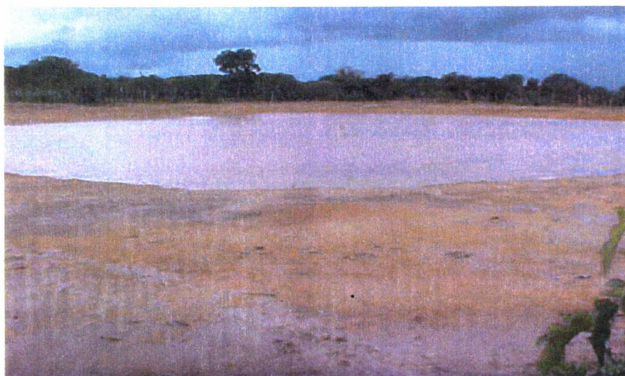
Fig. 94 Exemplo de captação de água de chuva em lagoas ou açudes escavados no topo das chapadas, com redução da infiltração por meio de compactação da bacia hidráulica. Chapada do Araripe (Foto Lopes, 2002).
