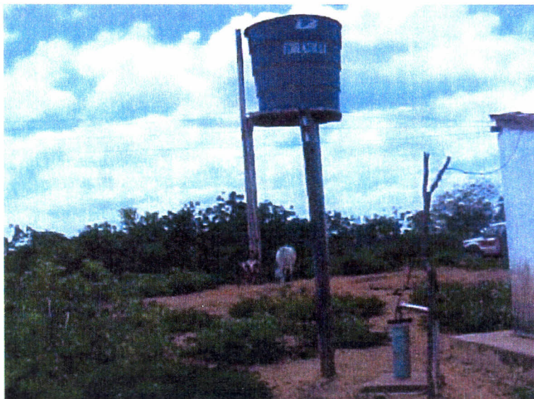
Fig. 107 – Exemplo de um poço tubular nas Chapadas Baixas, com detalhes da boca do poço com canalização de saída, cabo de força, casa de bomba, chafariz, caixa d'água. (ANA, 2001).
