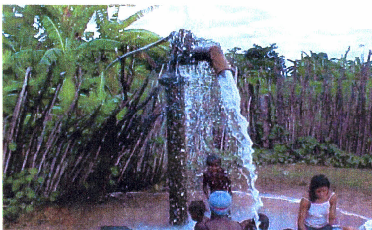
Fig. 108 – Foto de um poço tubular jorrante, com exemplo de desperdício de água. São João do Piauí.
