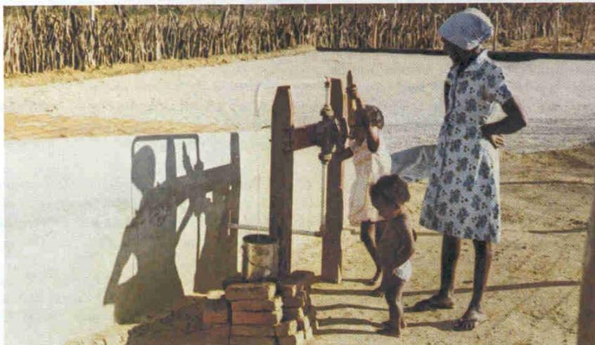
FIGURA 5. Cisterna equipada com bomba manual.
