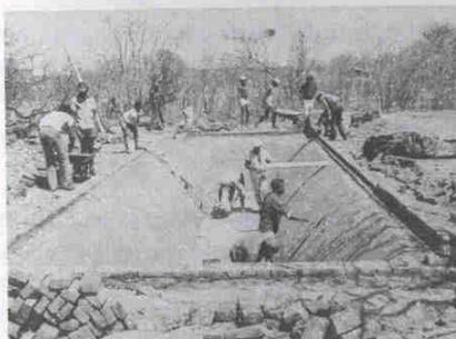
FIGURA 13. Revestimento com argamassa.
