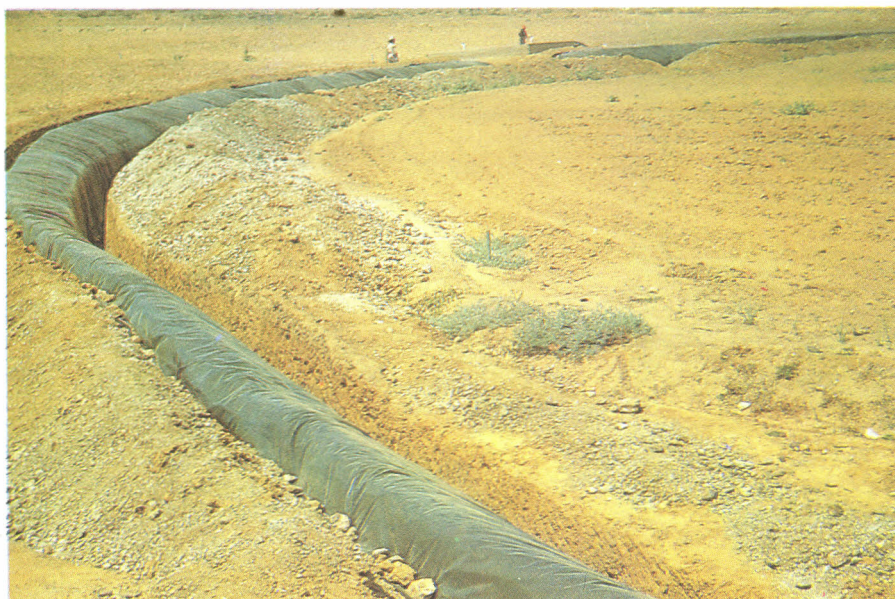
FIG. 5. Septo impermeável em lona plástica da barragem subterrânea.
