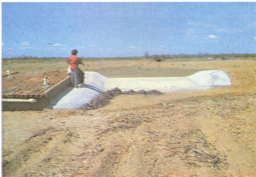
FIG. 6. Sangradouro da barragem subterrânea, localizado no centro da parede.
