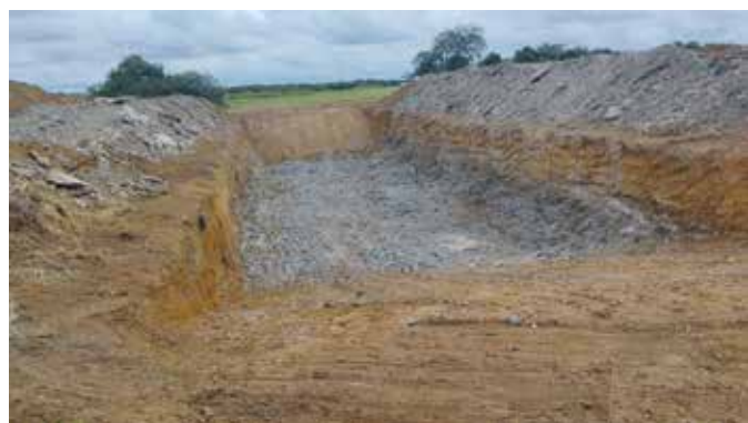
Construção de barreiro trincheira.
