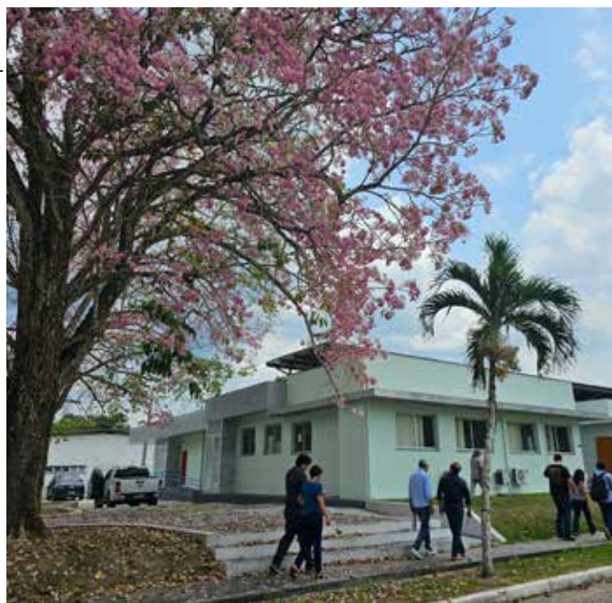
Reforma e ampliação do Laboratório de Biologia Molecular da Unidade.
