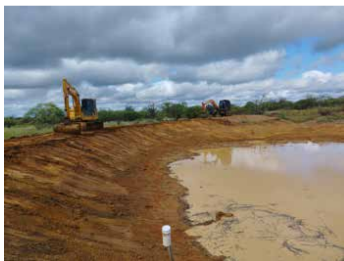
Máquinas recuperando barreiro de salvação.
