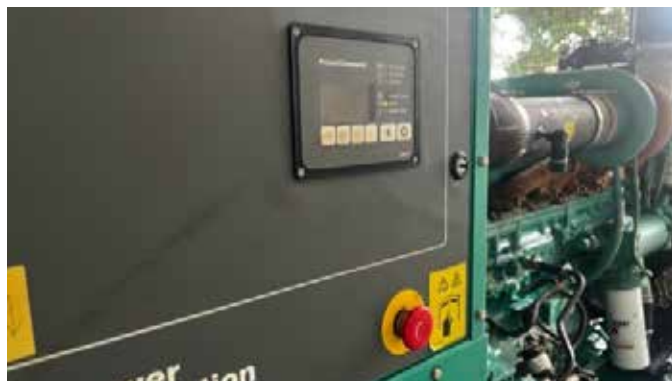
Revisão e limpeza do gerador.
