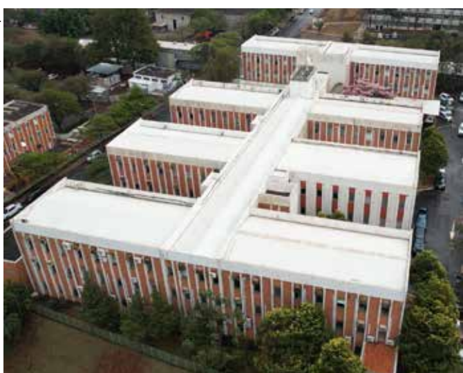
Modernização da infraestrutura da Unidade.
