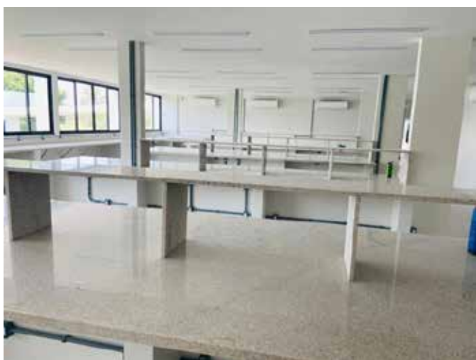
Reforma de laboratórios na Unidade.
