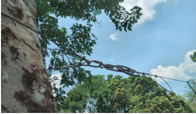
Figura 8. Alça-base ancorada ao cabo maior.
