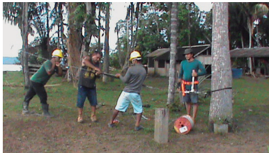
Figura 12. Tensionando o cabo de aço utilizando a catraca manual.
