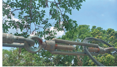
Figura 9. Esticador que auxilia no tensionamento do cabo de aço.
