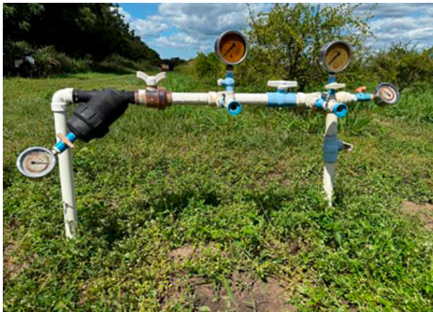
Figura 1. Cabeçal de controle com filtro de disco, manômetros e registros.
