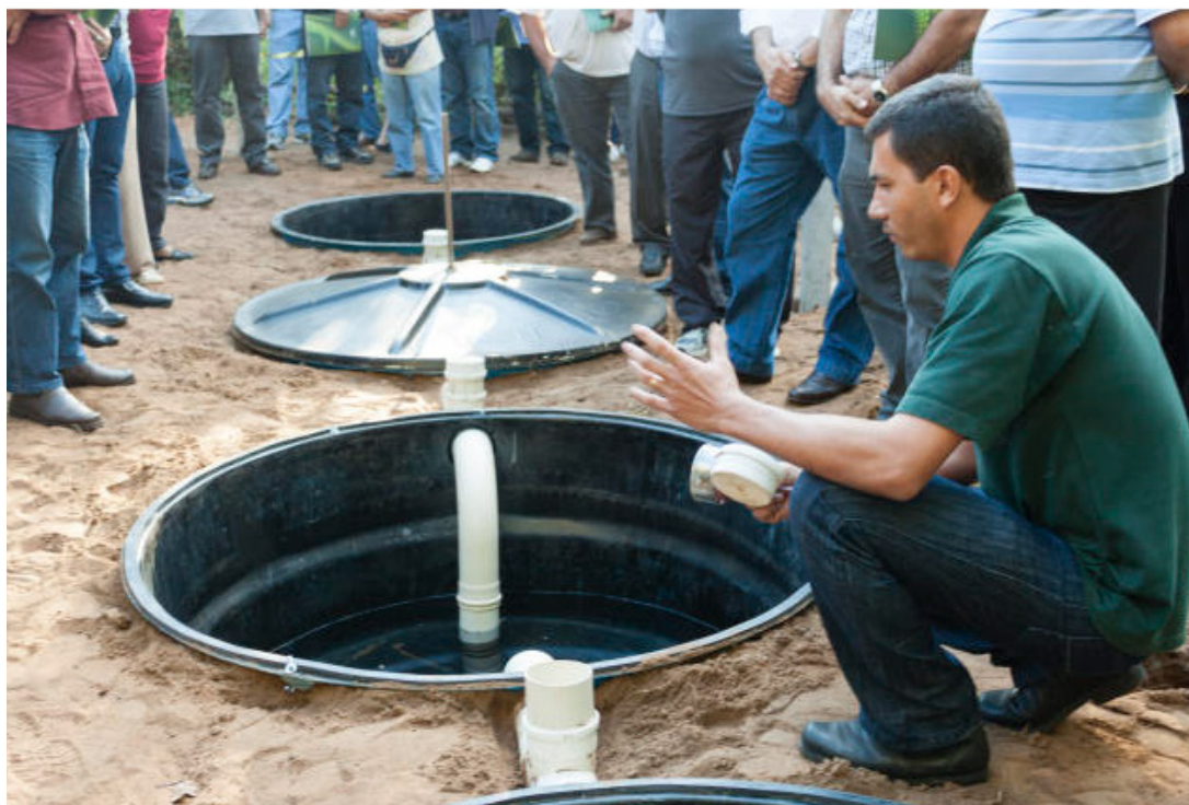
Figura 1. Fossa séptica biodigestora.
