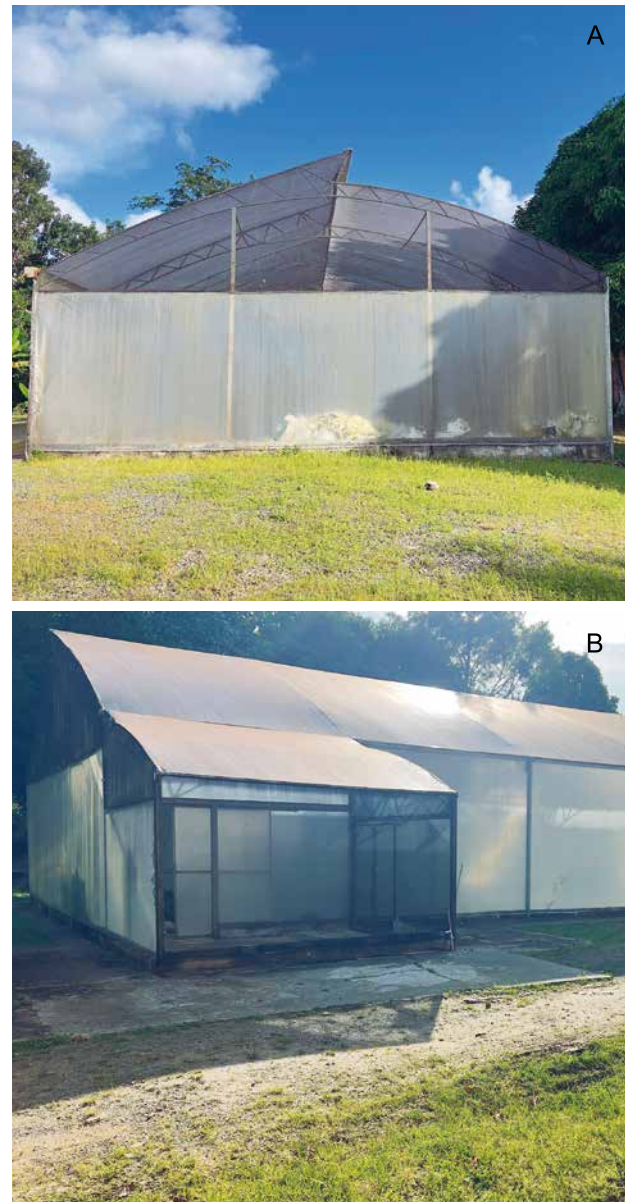
Figura 2. Detalhes do 'túnel de nebulização', visão externa com abertura zenital (A) e antecâmara de entrada (B). Instituto Biofábrica da Bahia.
