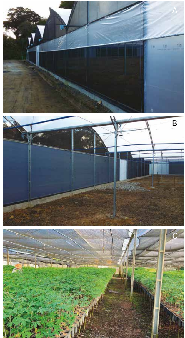
Figura 5. Estrutura de aclimatização final das mudas. Estufas com fechamento lateral de tela sombreadora 50% e cortina retrátil de plástico transparente. Abertura zenital (lanternim) na porção mais alta da curvatura dos arcos da cobertura (A e B). Irrigação por nebulização (C). Instituto Biofábrica da Bahia.
