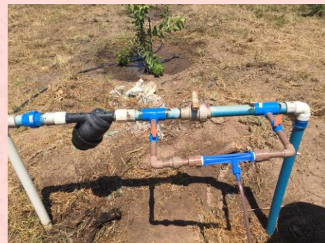
Figura 8. Cabeçal de controle com sistema de filtragem e injetor tipo venturi para fertirrigação.
