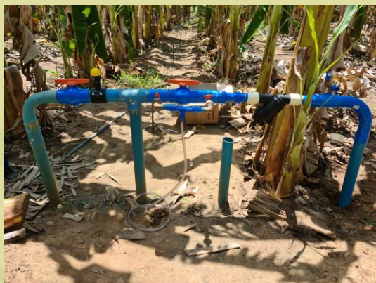
Figura 10. Cabeçal de controle contendo venturi para aplicações das caldas químicas na cultura da bananeira.
