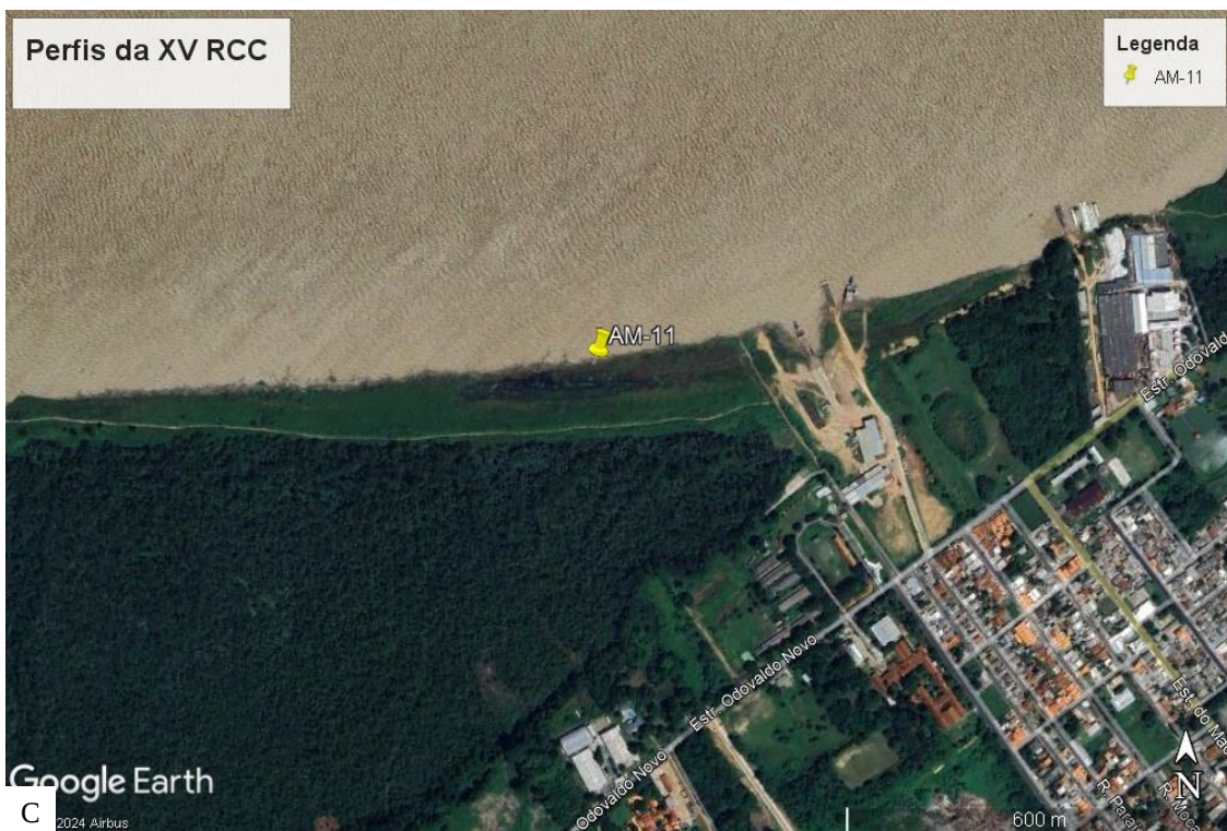
Figura 9.11. Fotografia mostrando fendas na superfície (A), ao lado do perfil AM-11 (B) e sua localização em imagem de satélite disponível no Google de 20/02/2024 (C) (Parintins, PA).
