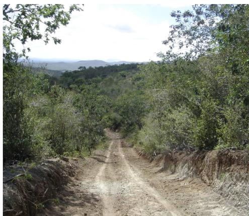
**Figura 24.** Estrada construída morro a baixo, sobre solos expansíveis, sem nenhuma técnica de preservação. Foto: Manoel Batista Neto.
