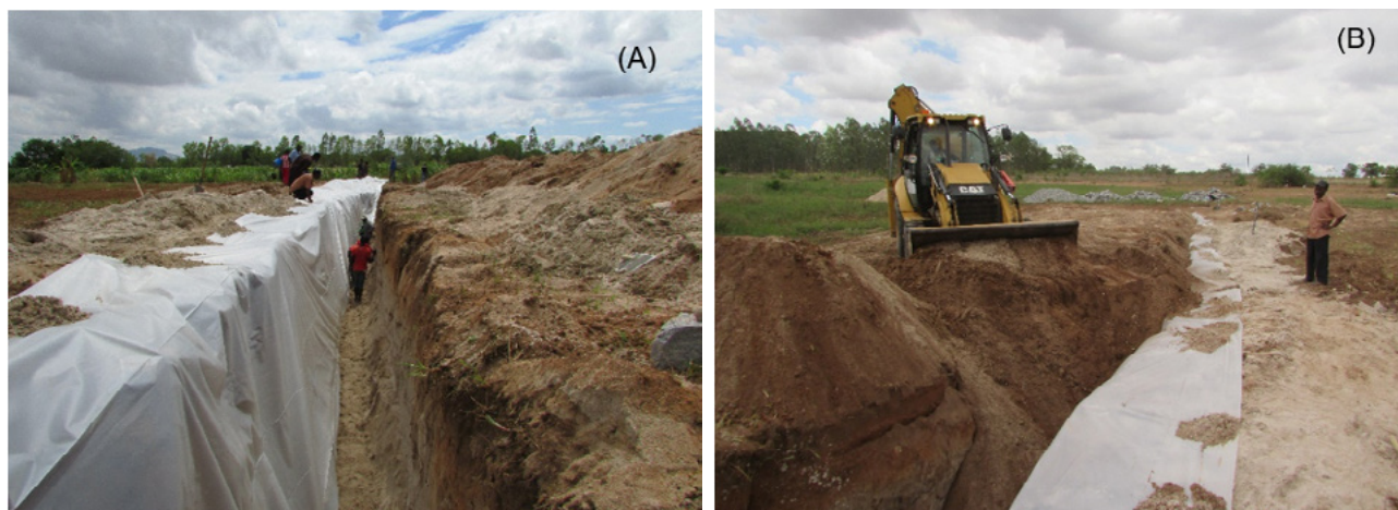
Figura 1. Vala de parede aberta impermeabilizada com o plástico (A); vala sendo fechada com a terra retirada na abertura (B). Fotos A e B: Flávio Adriano Marques.
