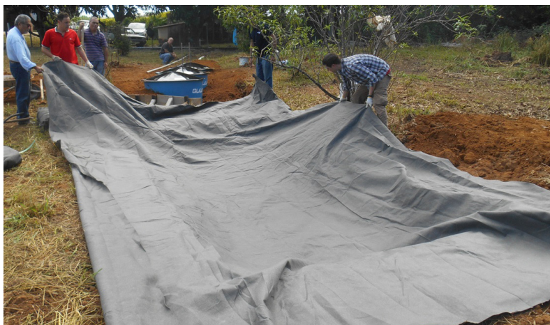
Figura 16: Colocação da primeira membrana geotêxtil. Acervo Embrapa.
