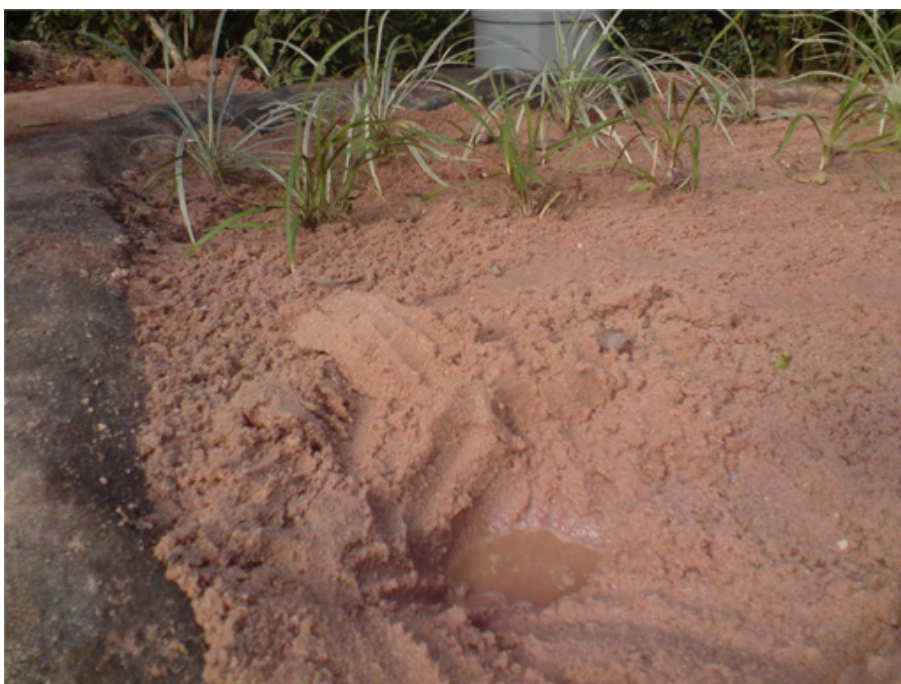
Figura 35: Foto do Jardim Filtrante em que se destaca que o nível da água fica um pouco abaixo do nível da areia. Acervo Embrapa.
