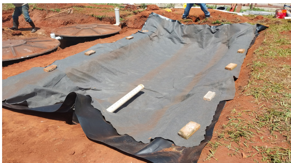
Figura 18: Colocação da membrana geotêxtil sobre a geomembrana. Em destaque, o cano de PVC furado, para drenagem do líquido tratado. Obs.: Nesta imagem aparece um tubo de PVC 100 mm de esgoto, mas pode também PVC 60 mm marrom. Autoria: Wilson Tadeu / Embrapa Instrumentação.
