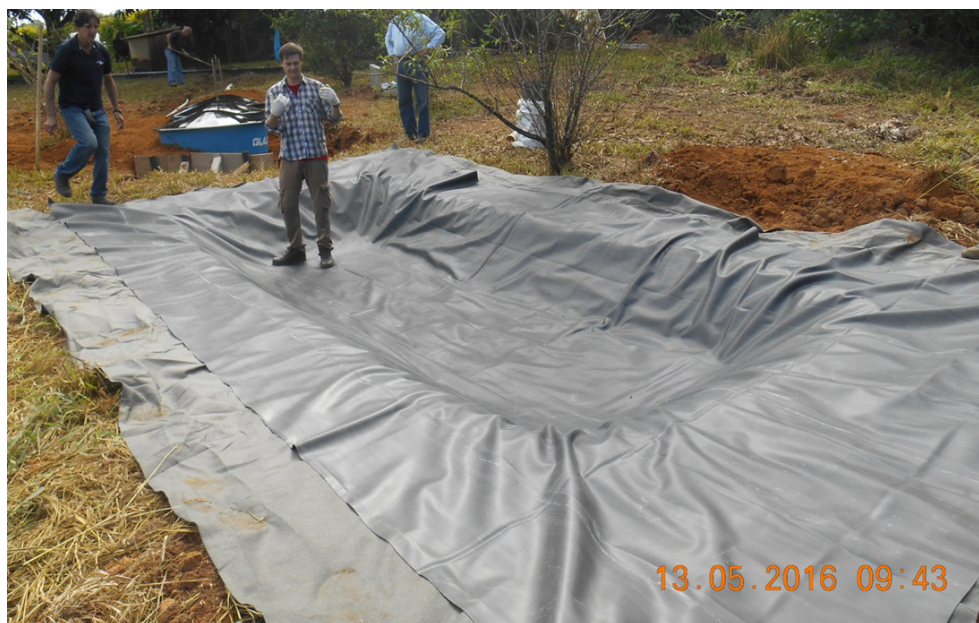
Figura 17: Colocação da geomembrana (EPDM ou equivalente). Acervo Embrapa.
