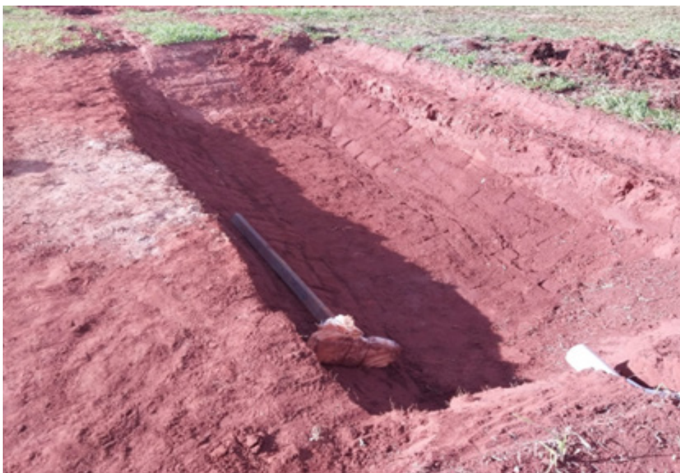
Figura 13: Local onde será instalado o Jardim Filtrante. Detalhes da foto: (i) Note a posição da tubulação de entrada e (ii) Foi necessário o uso de compactador manual (socador) para acomodar o solo das laterais. Acervo Embrapa.
