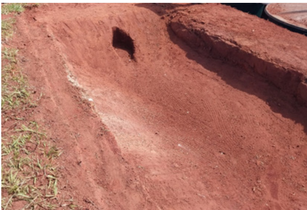
Figura 14: Entrância feita na posição de saída do Jardim Filtrante, onde será instalado o Monge. A partir daquele ponto, será feita a rede de saída do líquido tratado. Acervo Embrapa.
