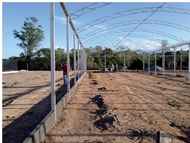
**Figura 5.2.** Vista das muretas laterais para evitar entrada de águas, em Lençóis, Chapada Diamantina, BA.
