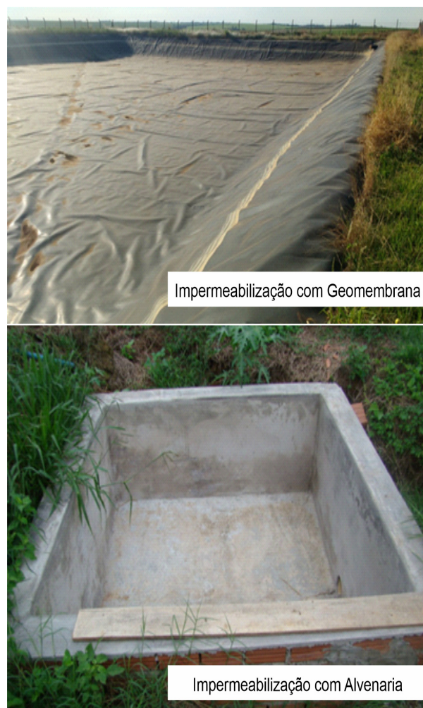
Figura 9. Exemplos de impermeabilização.
