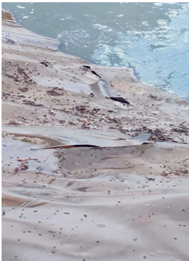
Figura 10. Geomembrana rasgada.
