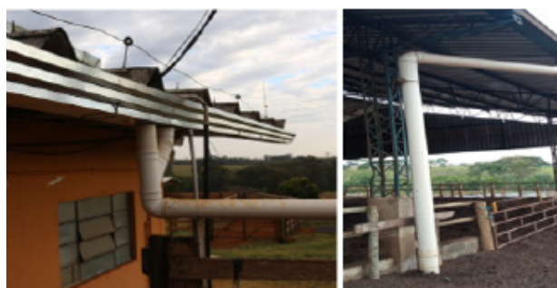
Figura 11. Calhas instaladas em telhados da ordenha.
