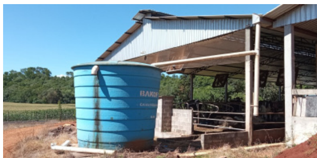
Figura 7. Cisterna captando água de telhado de confinamento.
