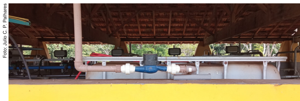
Figura 3. Hidrômetro instalado na sala de ordenha.
