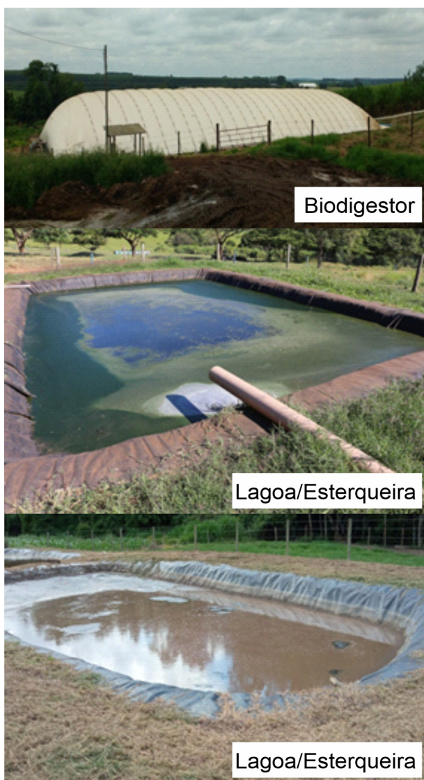
Figura 8. Exemplos de sistemas de armazenamento ou tratamento de dejetos.
