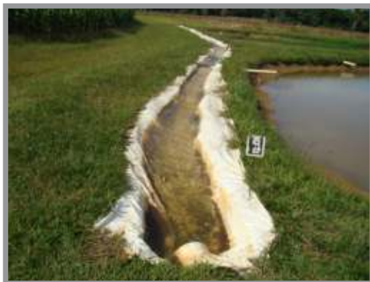
Canal de abastecimento de água por gravidade.
