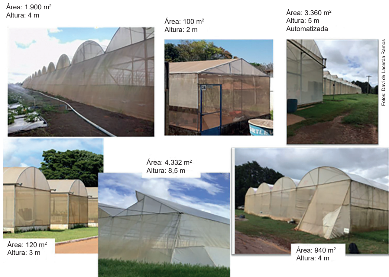
Figura 5. Diferentes modelos de casas de vegetação usadas em cultivos protegidos no Brasil.
