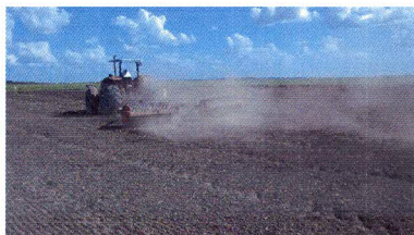
Rolagem – Rolo compactador
