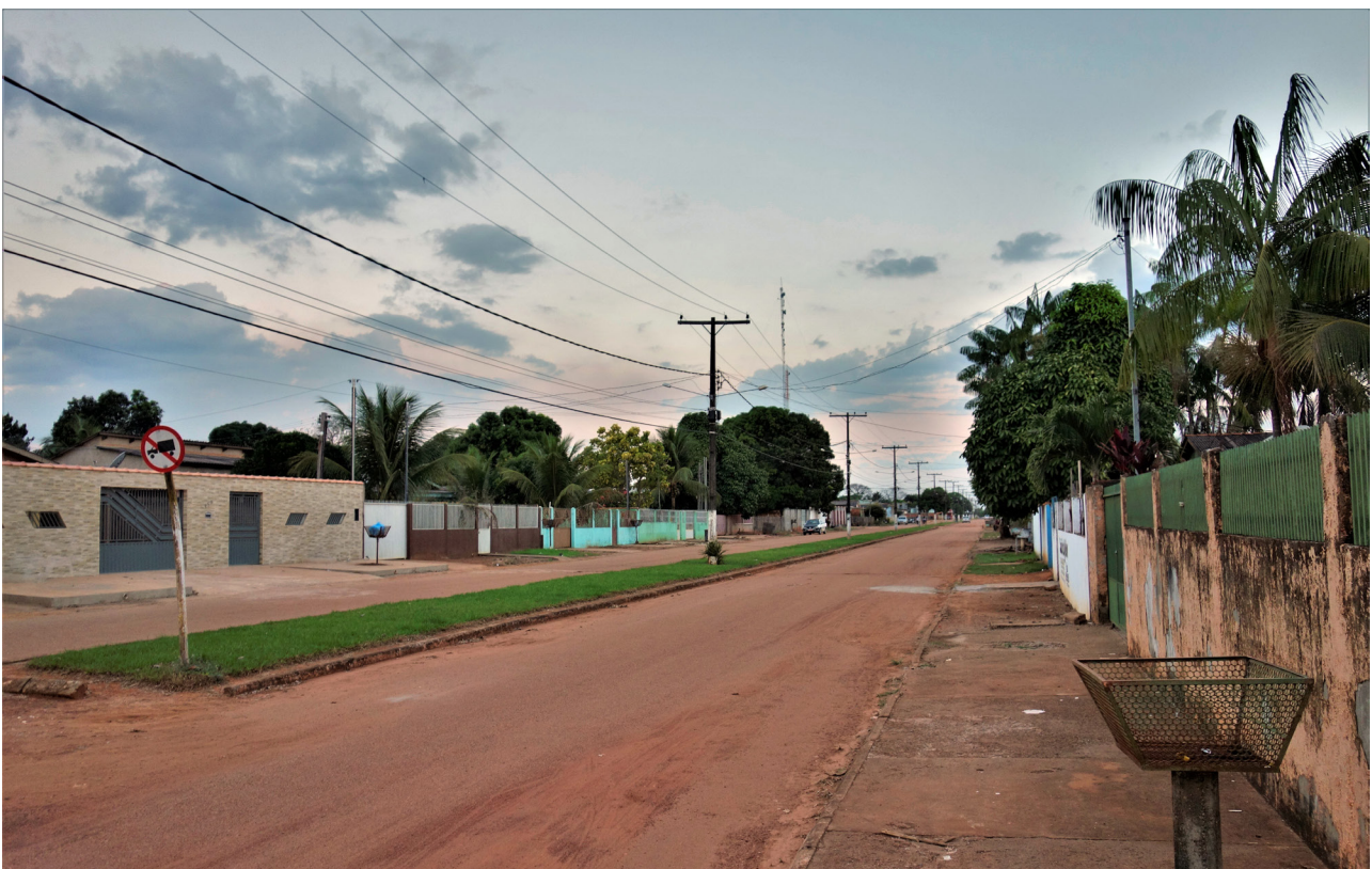
Figura 20. Aspecto de área urbana com densidade média de edificações e via pavimentada na cidade de Acrelândia. Localização: 67°03'06,64" W; 10°04'23,67" S.
