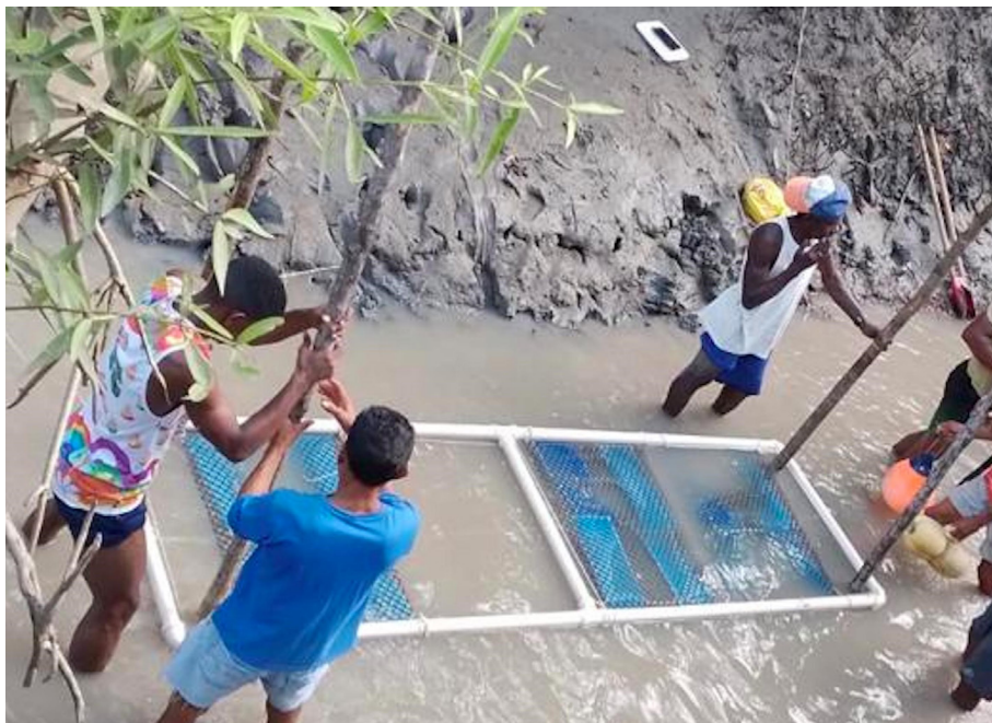
Figura 12. Traves instaladas nas laterais da mesa para evitar o deslocamento lateral no canal.
