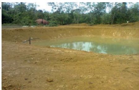
Figura 22. Açude em Latossolo Amarelo.
