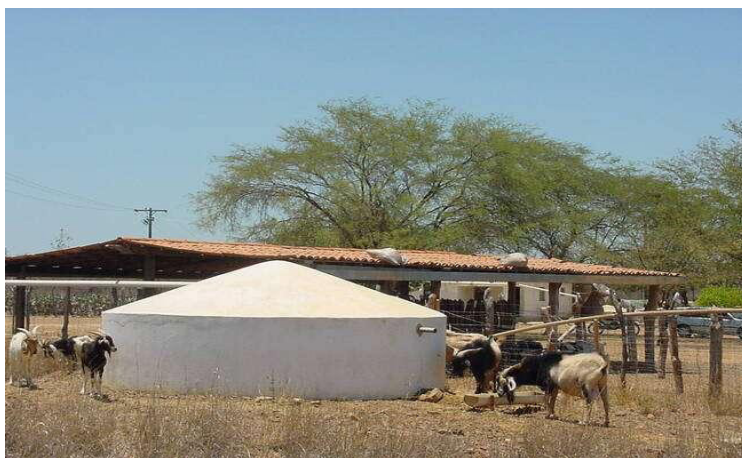
Figura 14 – Cisterna para consumo de pequenos animais (caprinos e ovinos), com área de captação no telhado.
