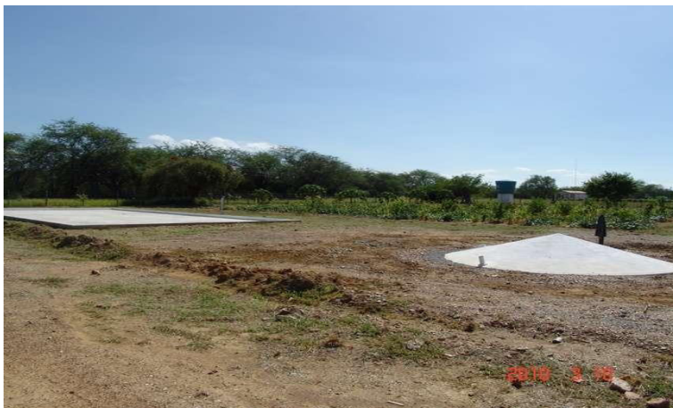
Figura 13 – Cisterna de produção de frutas e hortaliças com área de captação no solo.
