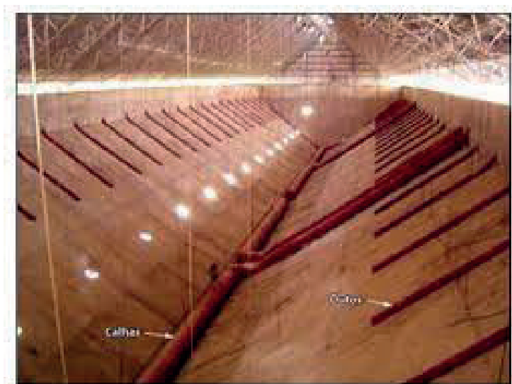
Figura 4. Armazém graneleiro fundo côncavo com aeração.
