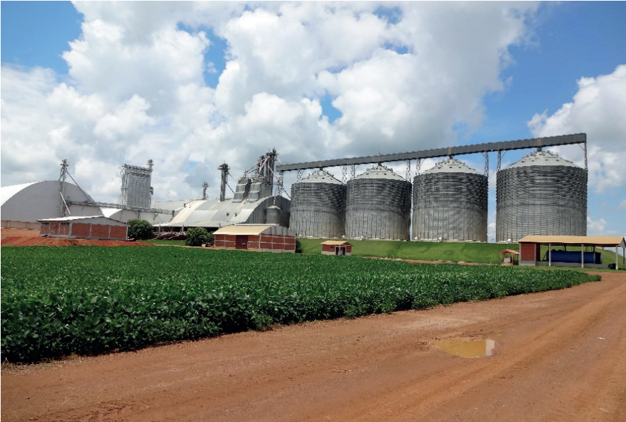
Figura 5. Complexo de silos e armazéns graneleiros.
