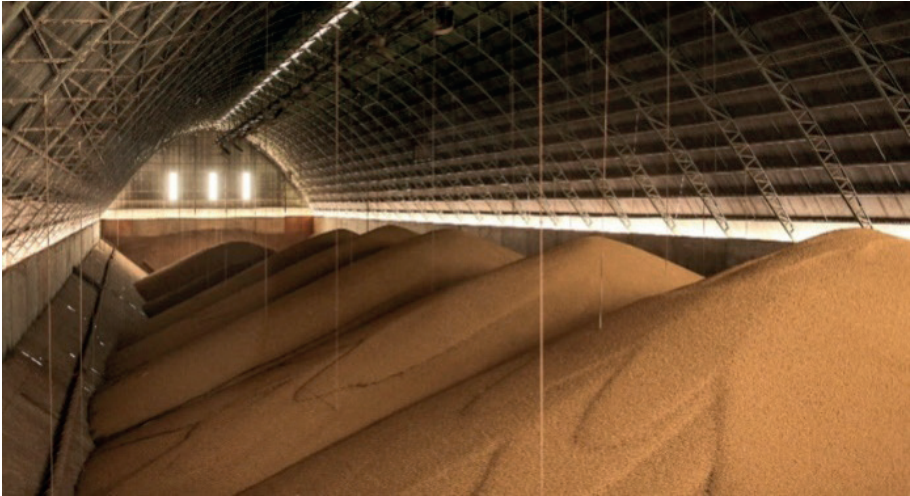
Figura 13. Armazém graneleiro fundo côncavo mostrando os cabos com sensores termoelétricos de temperatura.
