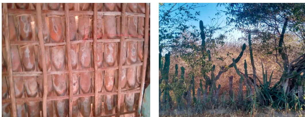
Figura 3. Caibros e ripas feitos com a madeira do mandacaru em (A), cerca viva em (B)
